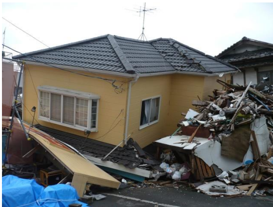
平成 28 年熊本地震被害状況
