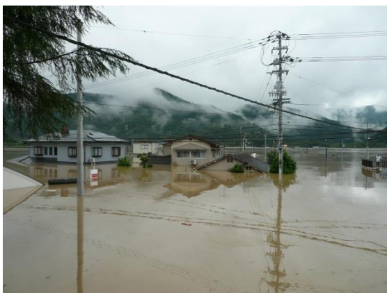
平成 30 年 7 月豪雨被害状況（大洲市）
